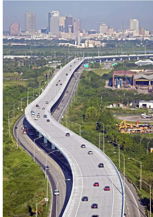
Selmon 快速公路高架調撥道空拍畫面
