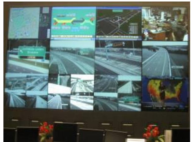
控制室監控畫面
