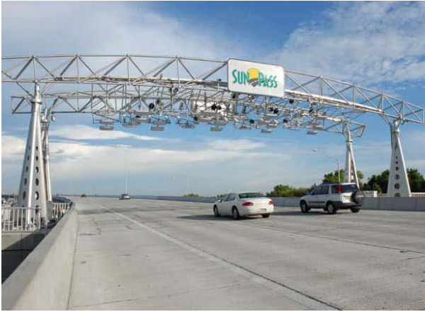
高架道路上之收費設備門架
