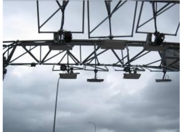
收費設備(ETC 感應器及車牌辨識 CCTV)
